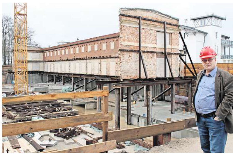
Architekt Klaus Klingler vor der Baugrube an den Kolonnaden in Heiligendamm.
